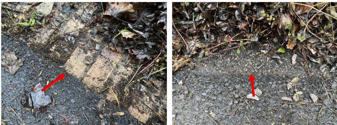
Abbildung 6: Anschlussbereich Asphaltdecke / Mauerkrone, links: unterer Bereich der Straße, Mauerkrone aus Ziegeln, rechts: oberer Bereich der Straße, Mauerkrone aus Beton
